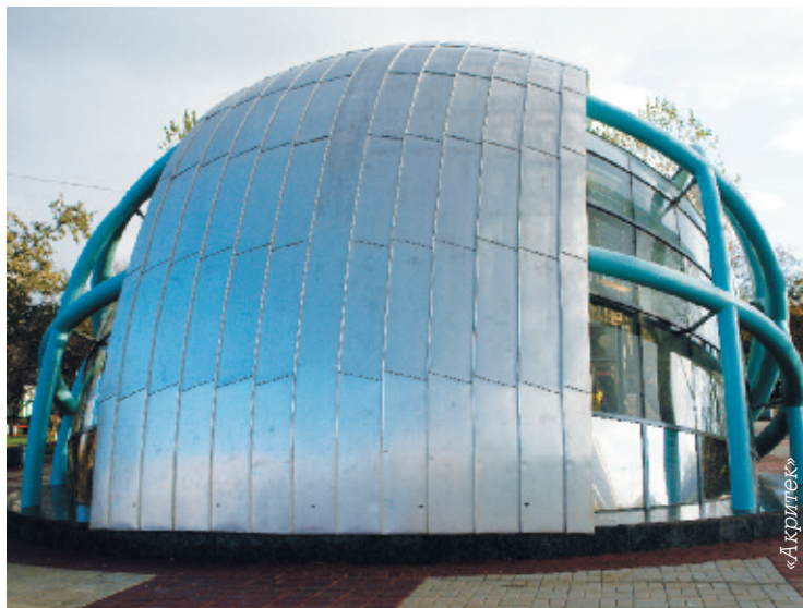
Узел примыкания к трубе из алюминия Pigea, выполненный вручную
