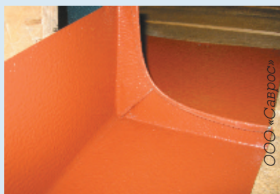
Узел примыкания к трубе из алюминия Pigea, выполненный вручную
